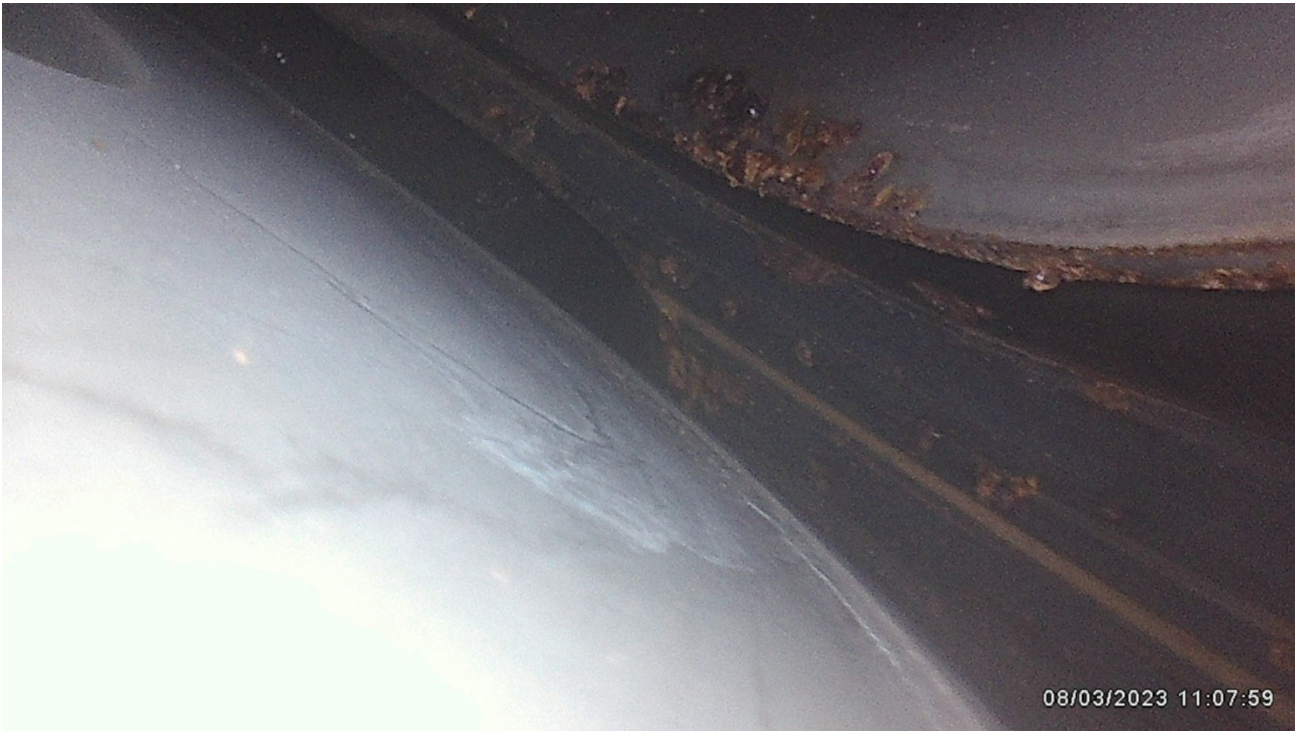
HD- Turbinenschaufel mit Ablagerungen
